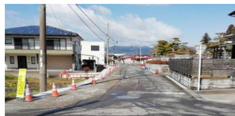
（工事中の市道 - 3月末撮影）
